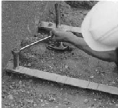
**Figure 2. Photo. MSE inextensible reinforcement—steel strips.**<sup>(3)</sup>
