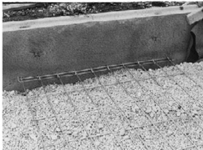
**Figure 3. Photo. MSE inextensible reinforcement—wire mats.**<sup>(3)</sup>
